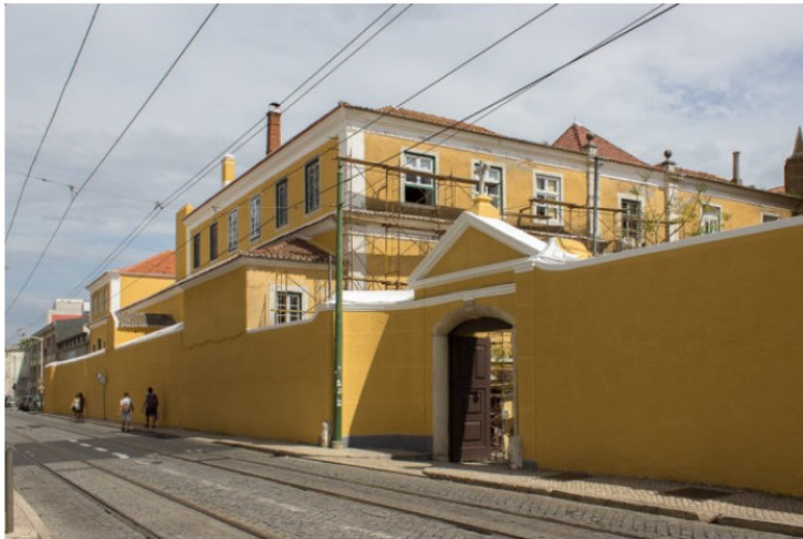
Convento de Nossa Senhora do Bom Sucesso | Exterior | Fachada Norte | Sara Pereira 21-04-2015
