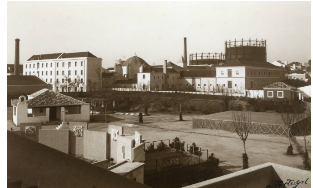
1900 a 1958 _ Fotografia de Eduardo do Convento de Nossa Senhora do Bom Sucesso / Panorâmica / Gasómetro Fonte: Arquivo Municipal de Lisboa
