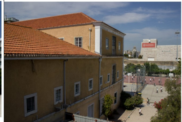
Convento de Nossa Senhora do Bom Sucesso | Exterior | Fachada Sul | Sara Pereira 04-06-2015
